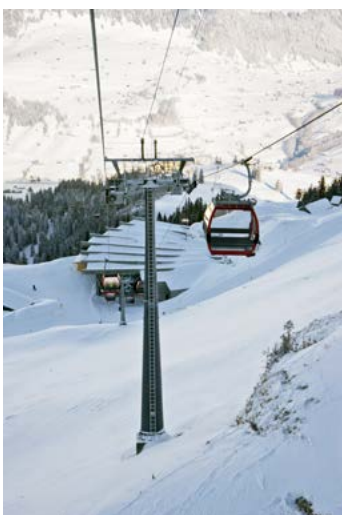
Bild 07 Blick auf Mittelstation
